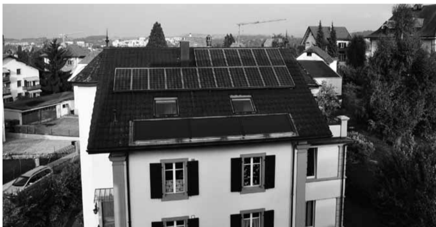
Ces capteurs solaires photovoltaïques, posés en patchwork sans intégration à la toiture, ajoutés à des capteurs thermiques, défigurent ce bâtiment des années 1900. Cette réalisation ne correspond ni aux exigences de la législation fédérale ni aux directives de la Conférence romande des délégués à l'énergie. En autorisant cette réalisation, les autorités locales n'ont pas fait leur travail. Et bonjour les dégâts!
