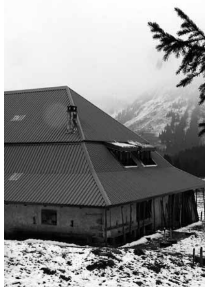
Le chalet du Lapé avec sa couverture de tôle et ses ouvertures dans la charpente. Inadmissible en présence d'un arrêté du Conseil d'Etat qui interdit cette pratique.
