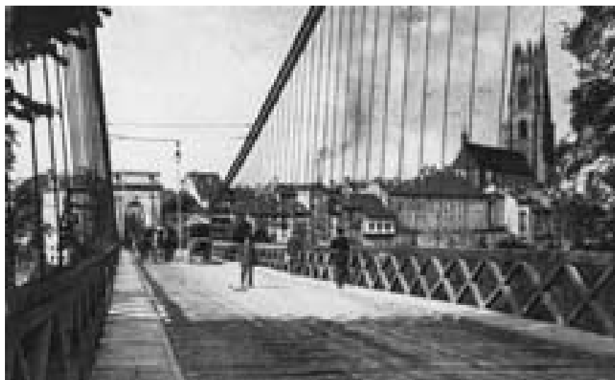
1834 Pont suspendu. Fribourg fait appel à un pionnier de cette technique novatrice, le français Joseph Chaley, d'une longueur de 265 mètres, c'est alors un record mondial et une réalisation sans accident ni dépassement de devis.
