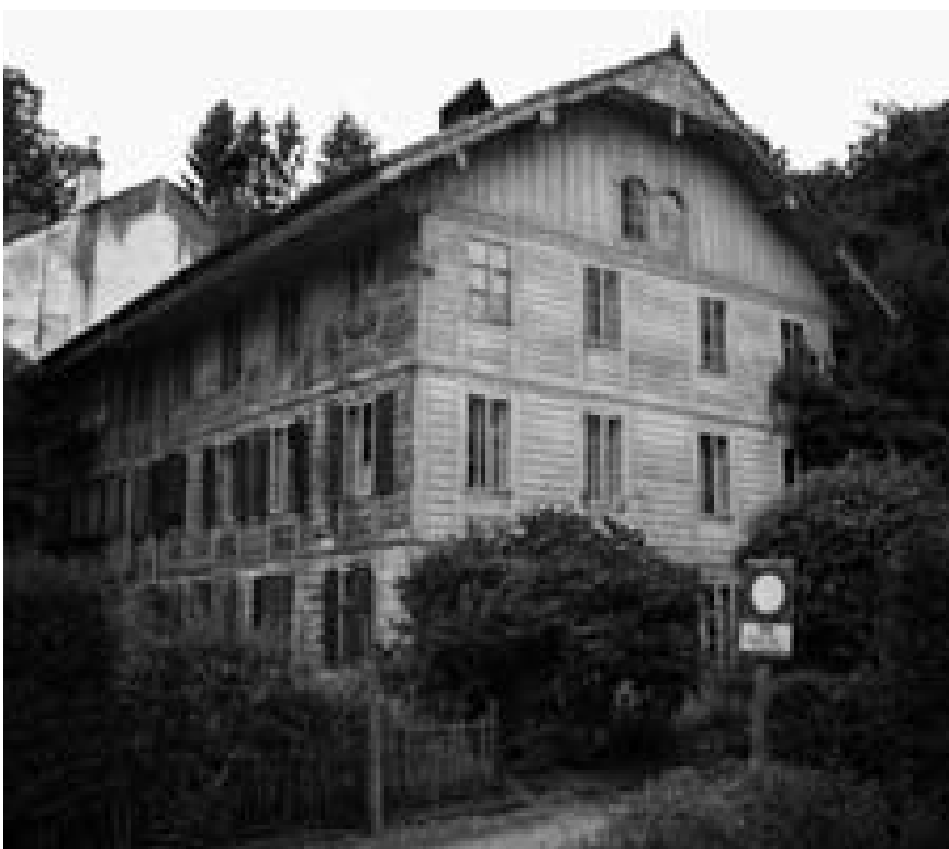
La partie en bois réservée aux logements des ouvriers témoigne du soin particulier apporté à la géométrie et aux détails d'exécution.
