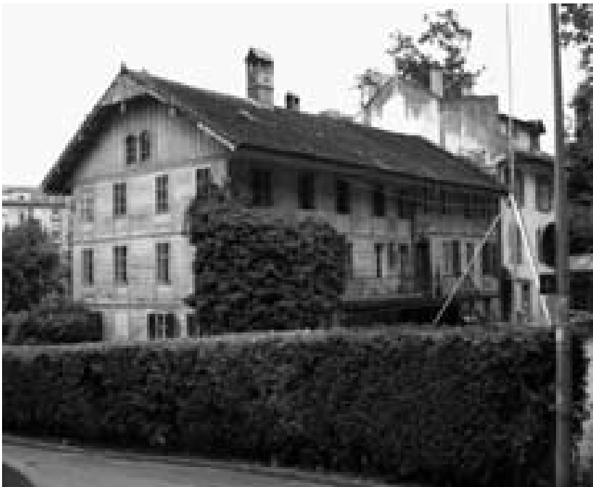
À Monséjour, la serrurerie Hogg. Au premier plan, en bois, les logements des ouvriers. À l'arrière en maçonnerie l'atelier et le logement du patron. On remarque au centre l'imposant mur coupe-feu.
