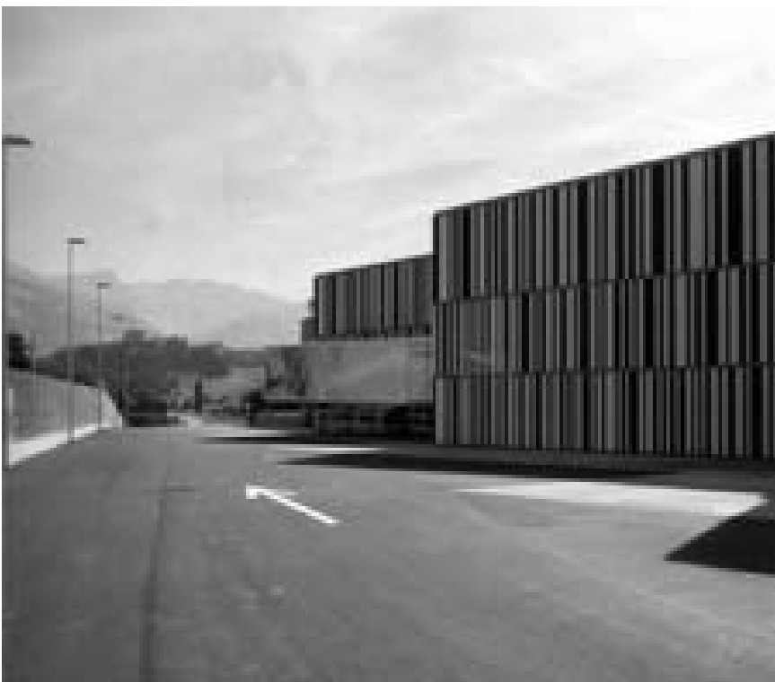
Yves André, Paysages occupés, La Tour-de-Trême . Cette Migros ne possède aucun accès pour les piétons et les cyclistes. Et aucun transport public en vue! Selon la Latec, tout cela est parfaitement illégal, mais si la commune et le canton n'exercent aucun contrôle, comment améliorer la situation?
