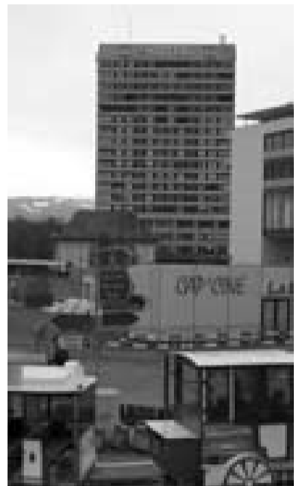
Une place à réaménager de toute urgence dans l'intérêt de la ville de Fribourg
