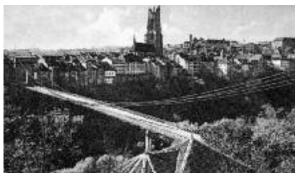
Le Grand Pont suspendu (1834 - 1924) de Joseph Challey remplacé par l'actuel pont de Zaehringen: une portée de 273 mètres!
