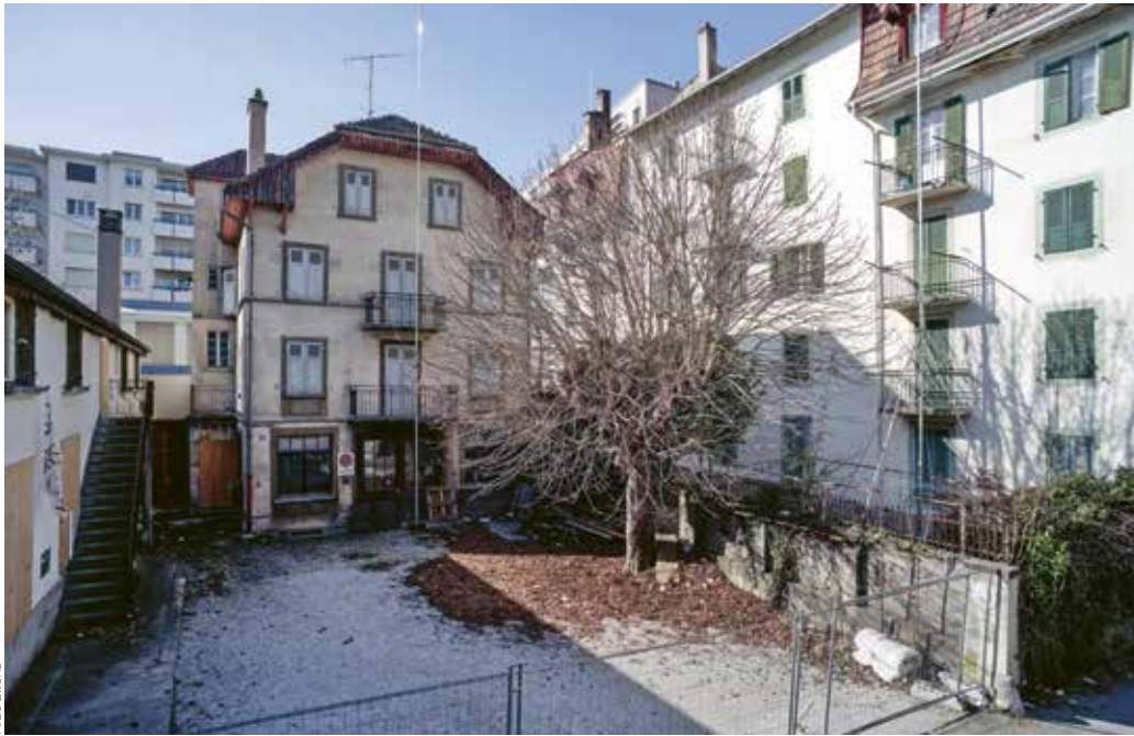
L'ancienne forge du Chemin de Richemond 5 et l'arrière du bâtiment de l'Avenue de Beauregard 8, un havre de paix au coeur de la ville
