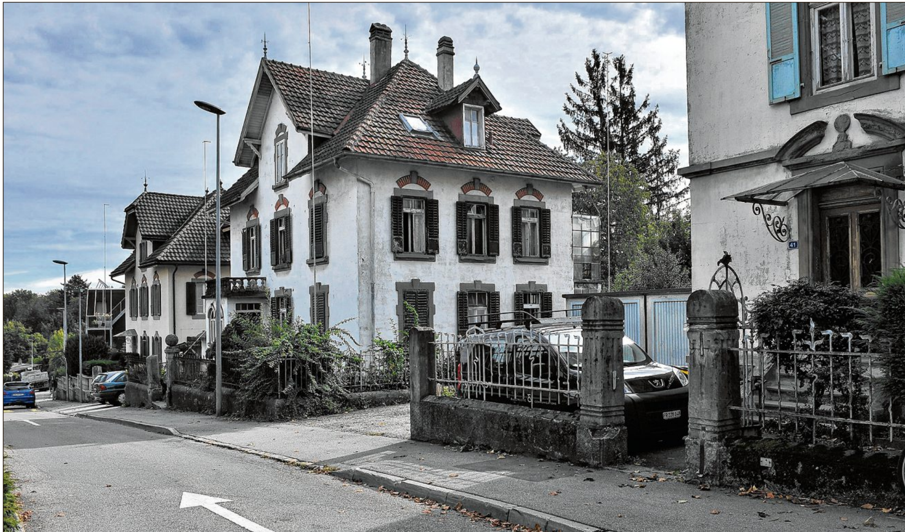
Les trois maisons, situées aux numéros 37, 39 et 41 de la rue des Daillettes, ne pourront pas être démolies. ALAIN WICHT-A
